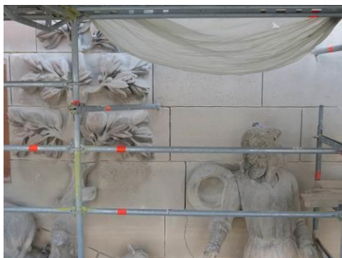
Echafaudage de la façade occidentale de la cathédrale (autour de la Grande Rose)
