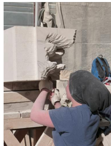
Sculptrice de pierre, chantier de rénovation
