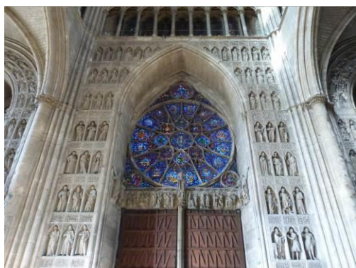
Porte d'entrée vue de l'intérieur
